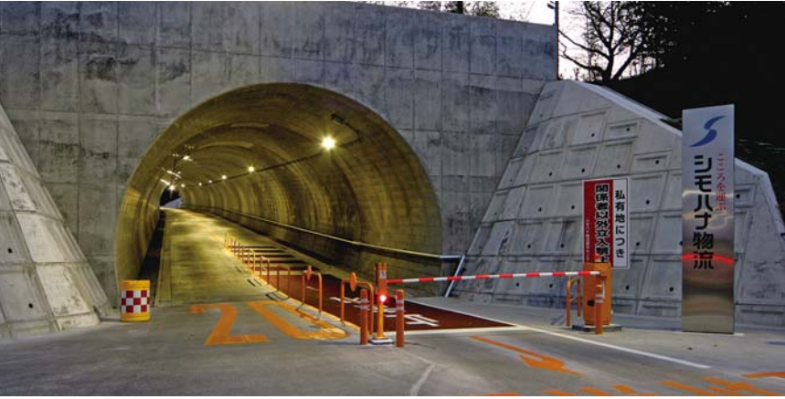
トンネル東口
